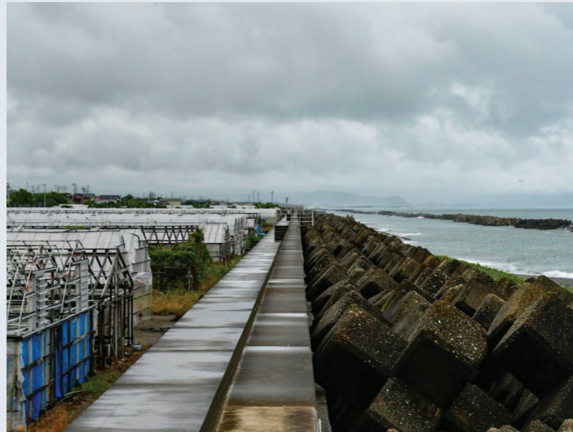
Photo 1 : Ouvrages de protection anti-tsunami sur le littoral de Kôchi
