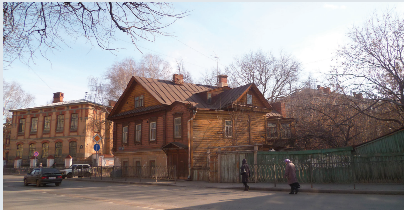
Photographie 2. Une des rares maisons en bois conservées dans le centre-ville de Kazan
